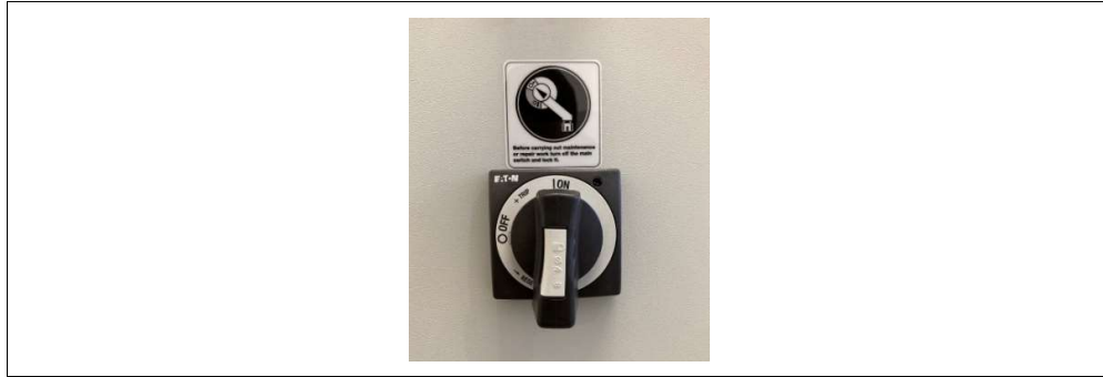
Abb. 11: Hauptschalter der ICU
