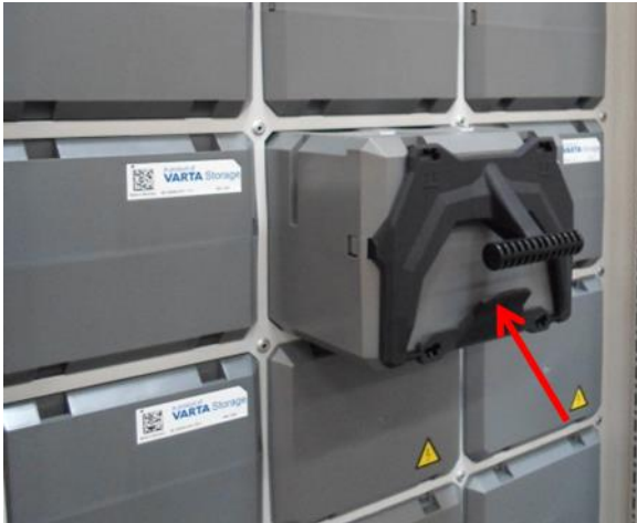
Abbildung 35: Batteriemodul mit Demontagehilfe
