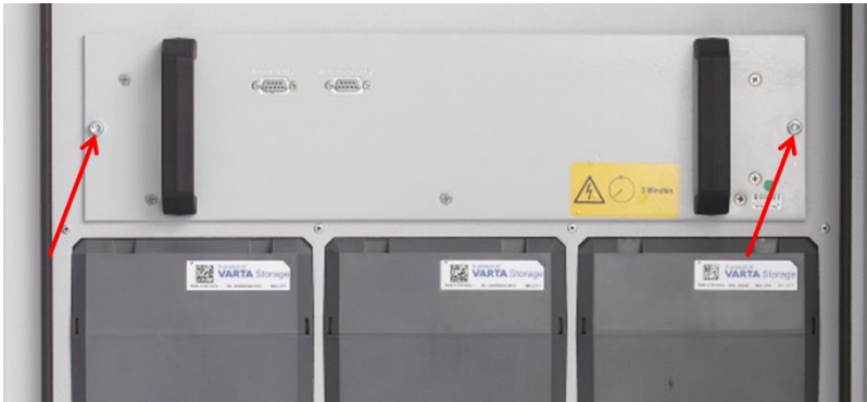
Abbildung 27: Schrauben am Batteriewechselrichter lösen
