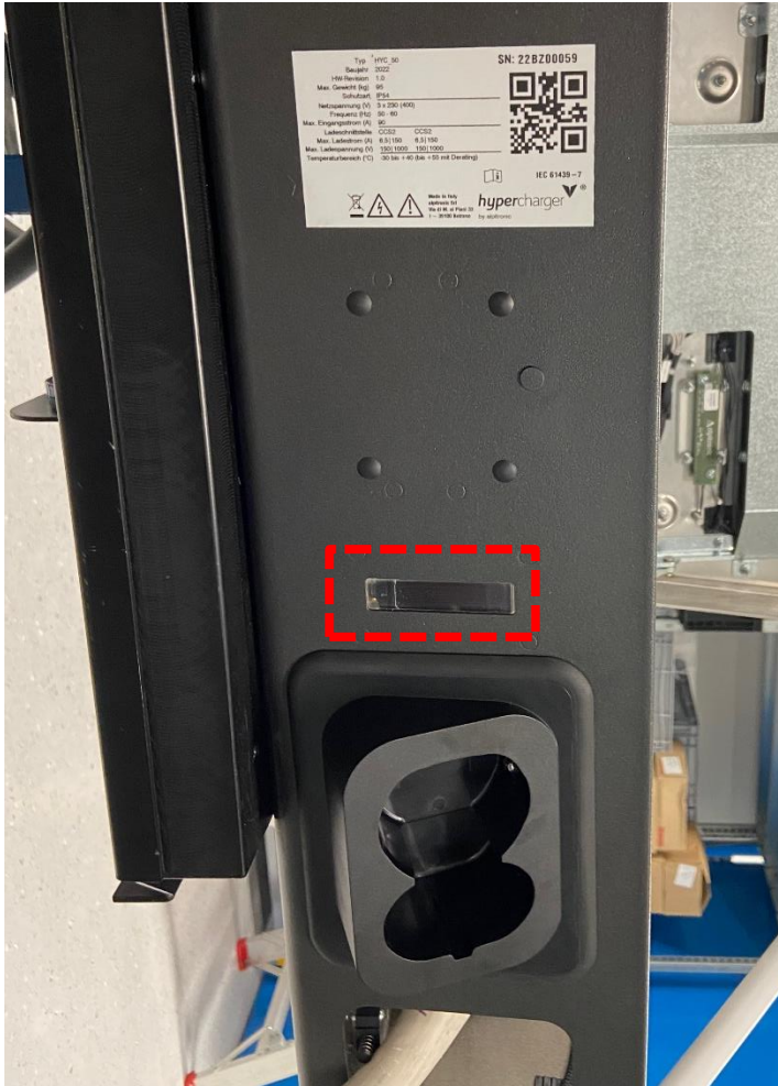
Abbildung 6: Position der abgesetzten eichrechtsrelevanten Anzeige in der Ladesäule (beidseitig).
